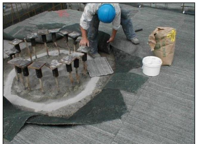
**Zugpfähle:** Voltex DS-Matte einschneiden und zwischen den Armierungseisen legen. Vor dem betonieren zusätzlich Cetco Granulat einstreuen.
