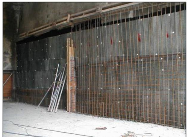
10. Wenn die Voltex DS-Matte nicht auf die ganze Wandhöhe angebracht wird, soll als Abschluss eine Distanzleiste (Ferrofix) montiert werden, damit sich die Voltex DS-Matte nicht löst, keine Umlegen der Voltex DS-Matte möglich ist.
