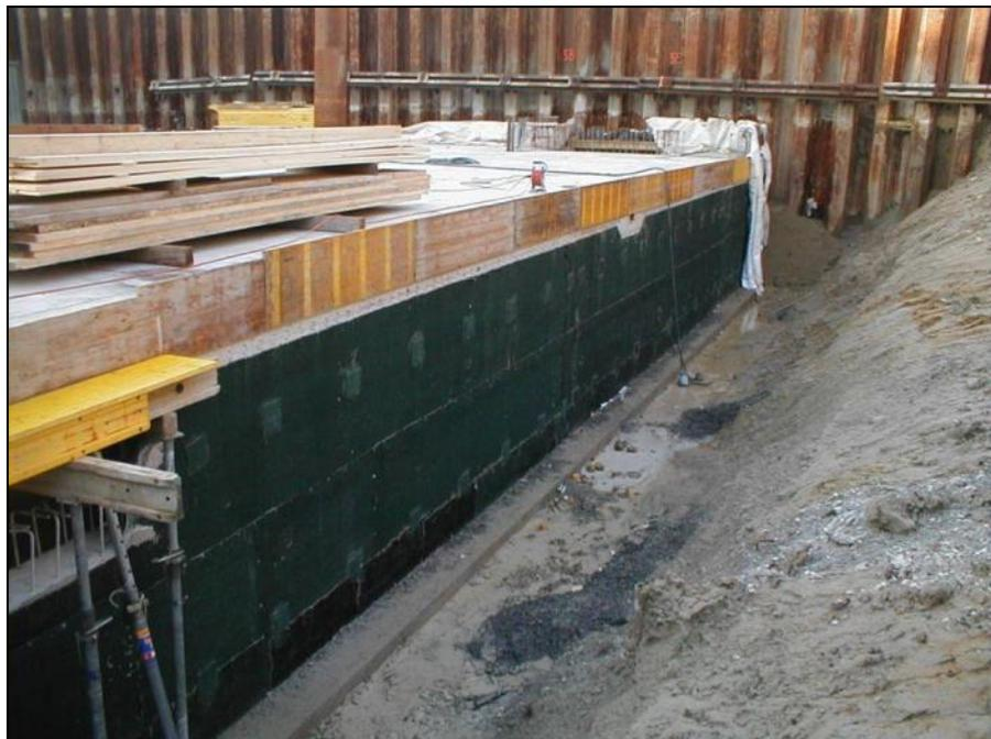
14. Bei Arbeitsfugen in Bodenplatte die Voltex DS-Matte mit einer 2. Voltex DS Lage 60 cm breit überdecken.
