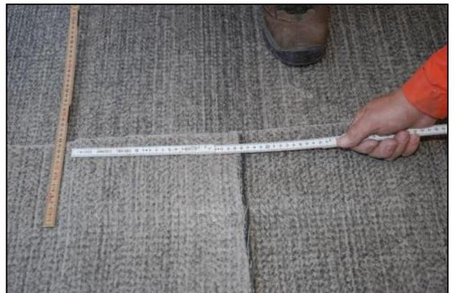
3. Voltex DS – Bentonitmatte Minimum 15 cm über Bodenplattenstärke an der Schalung hochziehen
