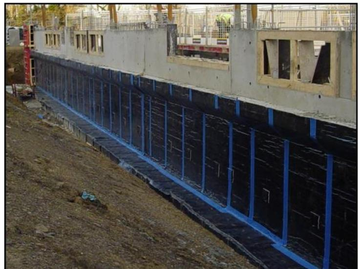
9. Bei der Abschalung der Wände ist die Voltex DS-Matte mindestens 25 – 30 cm weiterzuführen (Überlappung für 2. Etappe). Die Abschalung wird auf die Voltex DS-Matte montiert.
