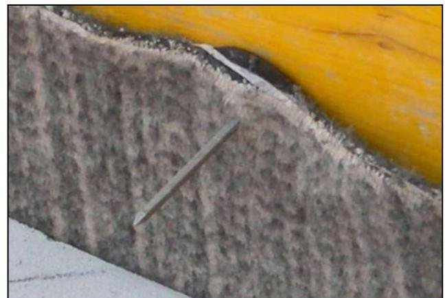
7. **Armierungsdistanzhalter (z.B. Ferrofix) auf Überlappung der Voltex DS-Matte verlegen in Längsrichtung.
