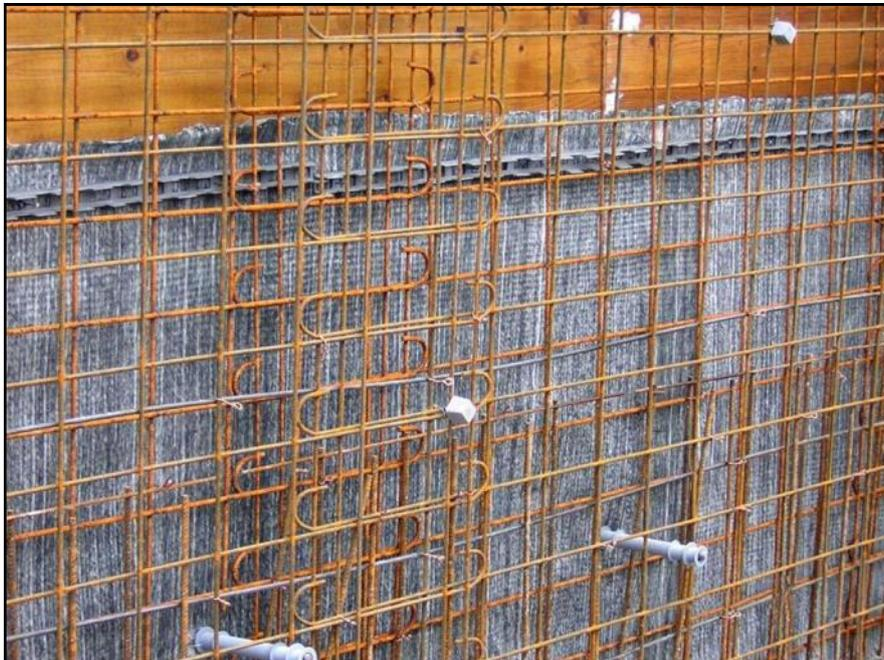
11. Bei Wandanschlüssen die rechtwinklig zur Hauptachse verlaufen, ist auf die Voltex DS-Matte betonseitig eine Plastikfolie zu montieren, damit sich die Voltex DS-Matte nicht verklebt und bei der folgenden Etappe in die Schalung genagelt werden kann.
