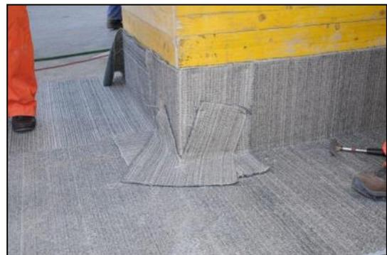
6. Bei Abschaltungen der Bodenplatte und auf Wandschalungen sind die Überlappungen mit 70er Leichtbauplattenstiften und Rondellen alle 25 – 30 cm von der Schalungsseite zu durchstossen. Die Nägel stehen in die Betonkonstruktion.
