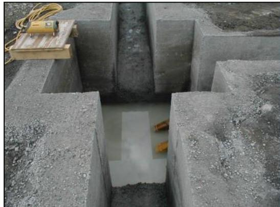
**Gunitwände und Unterfangungen: Die Oberflächen sind möglichst eben auszubilden, damit die Voltex DS-Matte flächig aufliegen kann.**
